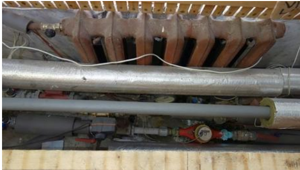
Joonis 2.2.10. Lasteaia soojussõlm
